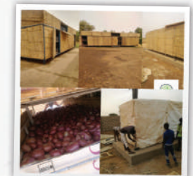
Complexe de Magasins de stockage d'oignon à Echangeur Géothermique conserve 100 tonnes d'oignon pendant 9 mois
